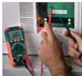
Dépanner les équipements électroniques et électriques
