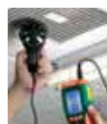
Mesure du débit de l'air dans les ouies de chauffage
