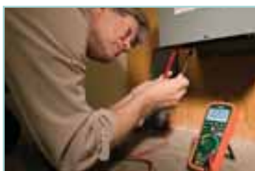
Application de catégorie IV de mesure de la tension sur un transformateur triphasé 480 V
