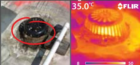
L'image thermique montre une fuite d'eau dans le toit.
