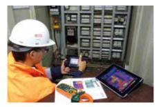
La caméra thermique FLIR transfère les images vers une tablette électronique par un réseau local sans fil.
