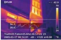
Image visible et image thermique d'un système de bus dans le hall de production.
