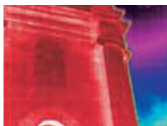
L'imagerie thermique révèle une ancienne fenêtre invisible à l'œil nu.
