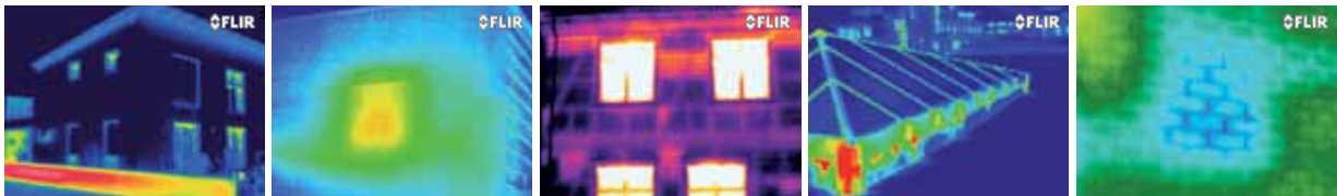
L'image infrarouge montre la qualité de l'isolation d'une maison peu économe.
