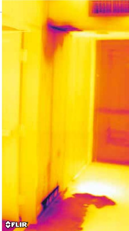
Domages causés par l'humidité dans un plafond, un mur et un sol.
