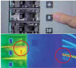
Avec l'imagerie thermique, les problèmes de connexion électrique, de câblage ou liés à d'autres composants apparaissent clairement sous la forme de "points chauds." Ils sont faciles à localiser et à réparer. Les connexions surchauffées sont parfaitement visibles sur l'image thermique.
