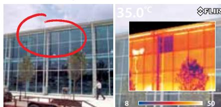
L'inspection thermique révèle une fenêtre installée de façon incorrecte.
