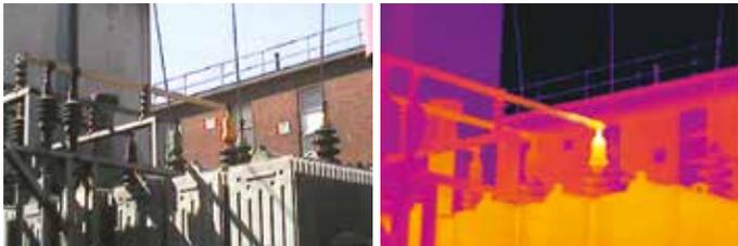
*Un plan large d'une sous-station peut révéler des zones où des connexions présentent une résistance anormalement élevée. Aucune autre technologie de maintenance préventive n'est aussi efficace que l'imagerie thermique pour l'inspection des installations électriques.*
