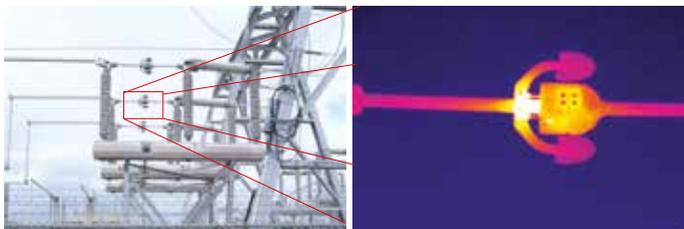
*Les caméras thermiques vous permettent d'inspecter les installations à haute tension à distance, ce qui améliore la sécurité de l'opérateur.*
