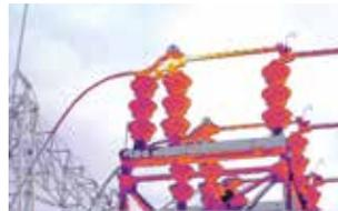
*L'inspection d'une sous-station fait apparaître des composants surchauffés.*
