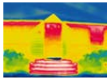
Bâtiment : déperdition énergétique
