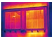
Bâtiment : déperdition énergétique
